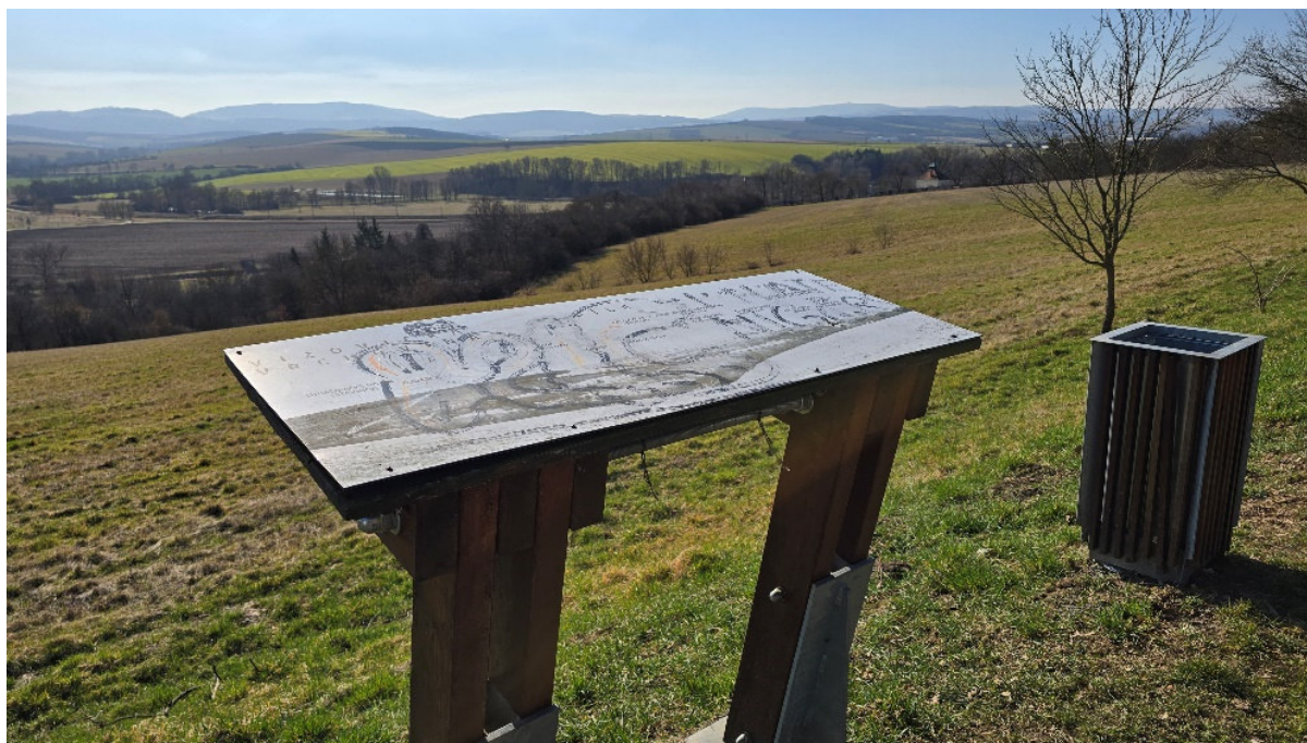
Poškození informační cedule – cyklostezka Újezdská
