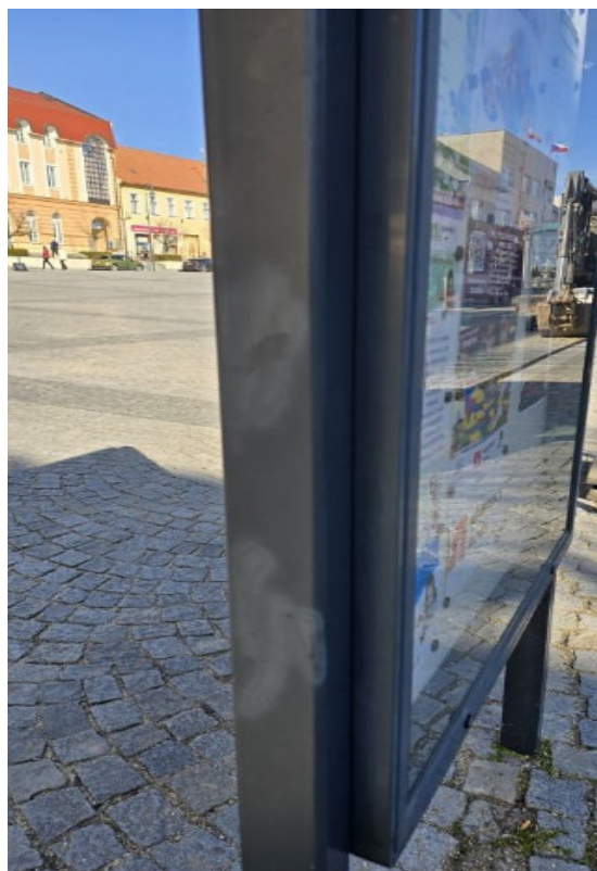
Vada barevnosti povrchu, Mariánské náměstí (zahrazovací sloupek a rám vitríny)
