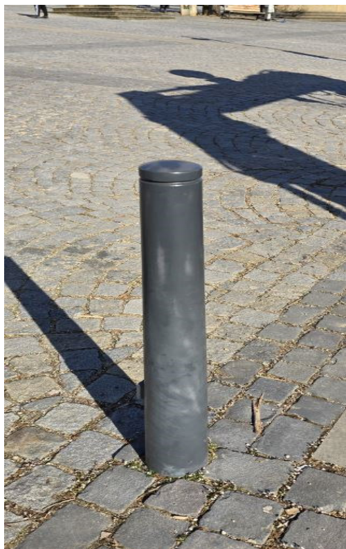
Vada barevnosti povrchu, Mariánské náměstí (zahrazovací sloupek a rám vitríny)
